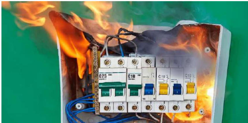
Şekil 2. Sigorta tablosu içinde meydana gelen yangın [5]
