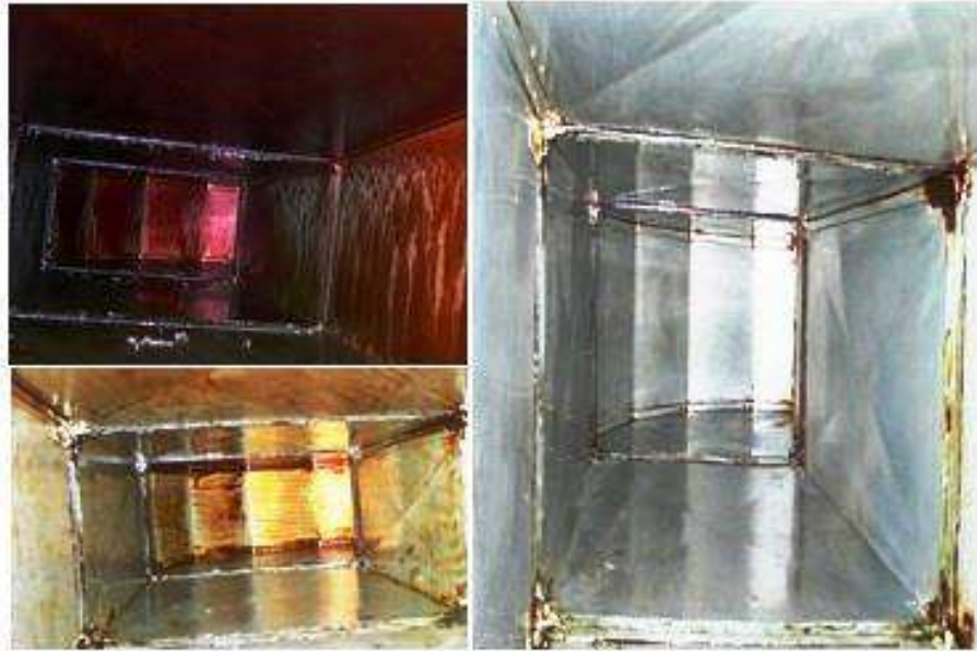
Şekil 11. Temizleme öncesi ve temizlenmiş yatay kanal (Hafif yağlı kanal – kazıma yöntemi – kimyasal temizlik)
