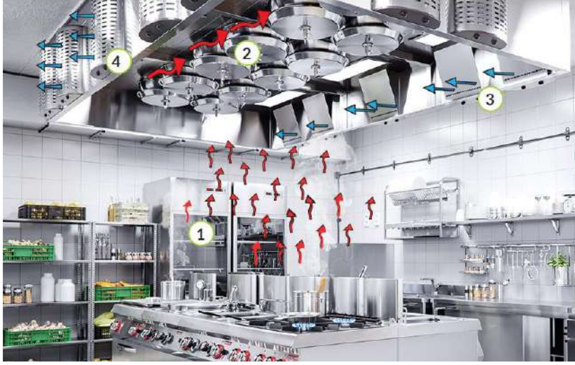
Şekil 13: Davlumbaz içi Yağ Ayırıcı Uygulaması.
