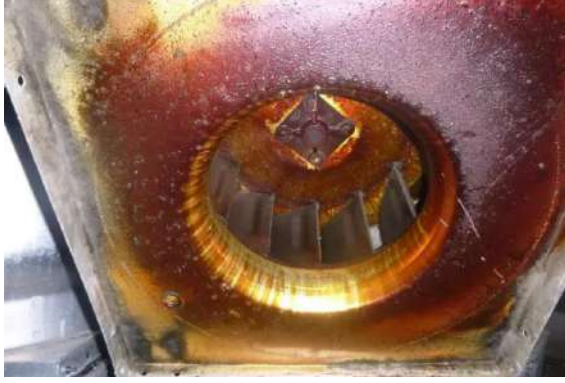
Şekil 24. Temizlenmesi gereken ve kimyasal köpükle temizlenmiş fan.
