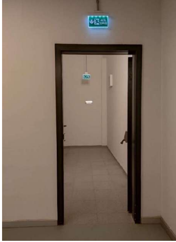
Şekil 9. Çalışma bölgesinde bulunan yangın merdiveni ve yangın kapısı
