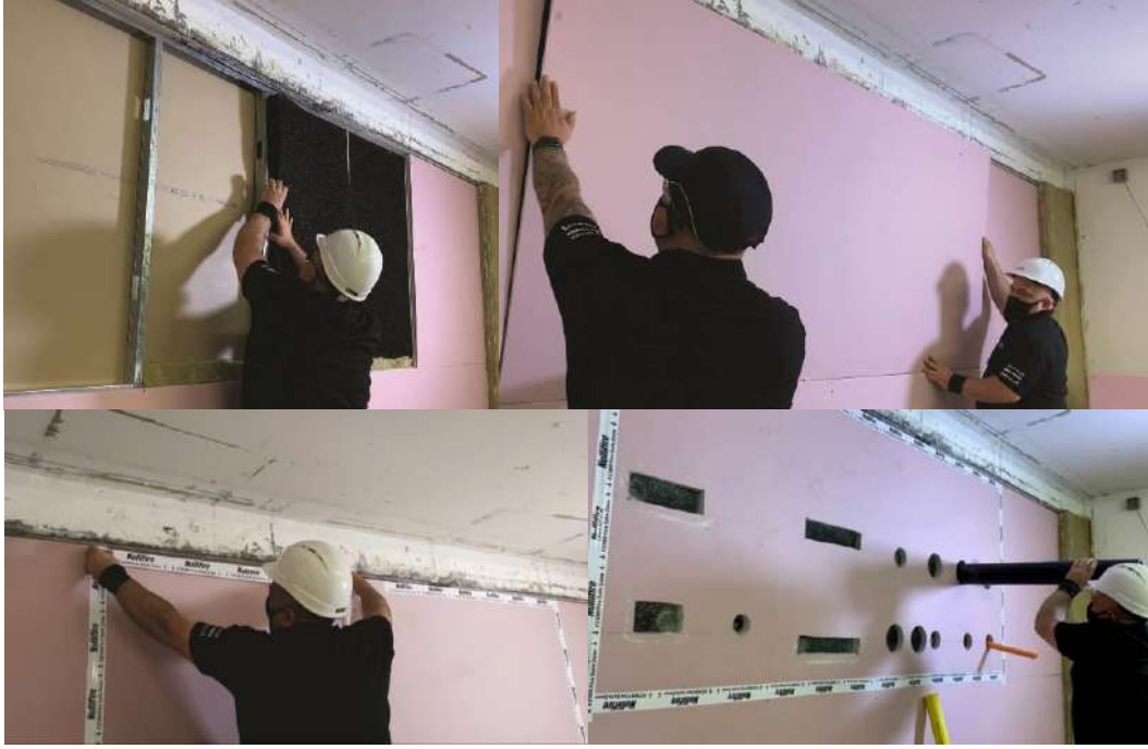
Şekil 5. İntümesan köpük levhanın uygulama adımları
