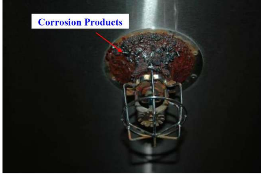
Şekil 2. Anot görevi gören çelik bağlantının, daha büyük katot görevi gören paslanmaz çelik plakaya teması nedeniyle yüksek nem olan ortamda oluşturduğu galvanik korozyon. (Kaynak: FM Global)
