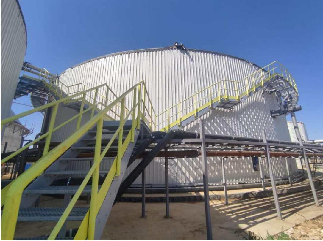
Şekil 3: Biyogaz Tesisleri Dış Merdiven
