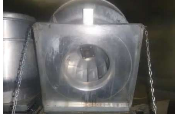
Şekil 24. Temizlenmesi gereken ve kimyasal köpükle temizlenmiş fan.
