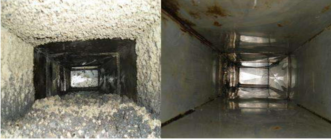
Şekil 10. Temizleme öncesi ve temizlenmiş yatay kanal (Çok yağlı kanal)
