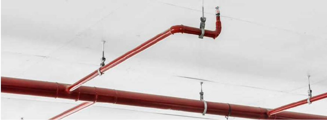
Şekil 8: Biyogaz ve Biyokütle Tesislerinde Kullanılabilen Yağmurlama Sistemleri
