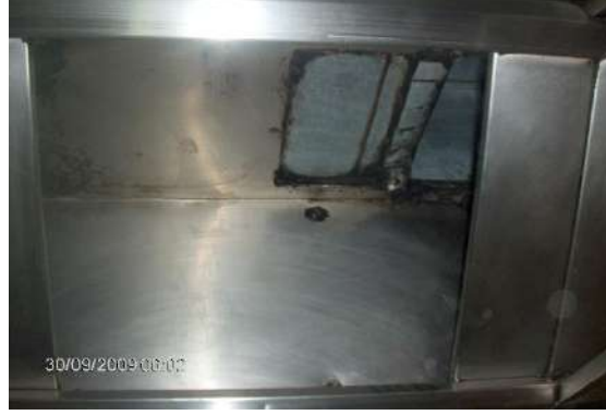
Şekil 9. Temizlenmiş olan emiş ağız uygulaması
