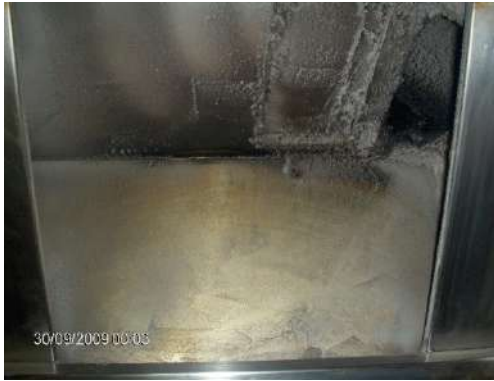
Şekil 8. Temizlenmesi gereken emiş ağız
