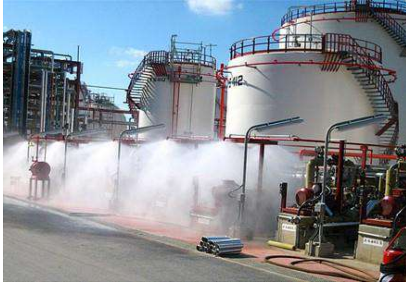
Şekil 9: Biyogaz ve Biyokütle Tesislerinde Ekipman Soğutmada Kullanılan Su Sprey Sistemleri
