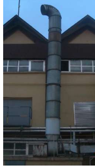
Şekil 26. Atış ağızı temizliği yapılmış bir kanal.
