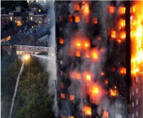
Şekil 3. Grenfell Tower Yangını (2)
