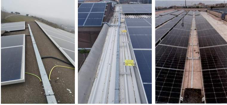
ÇATI ÜZERİ KABLO KANALLARI
